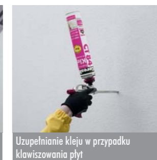
Uzupelnianie szczelin pomiędzy płytami styropianowymi
